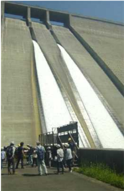
ダム下流広場の状況
